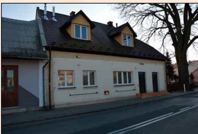
Budynek poczty w Radłowie współcześnie.
