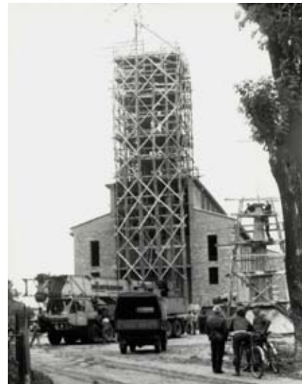
Kościół w trakcie budowy
