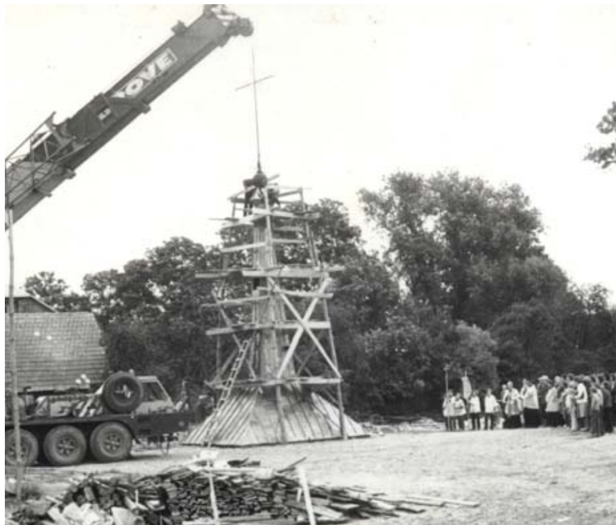
Montaż i osadzenie kopuły wieży kościelnej
