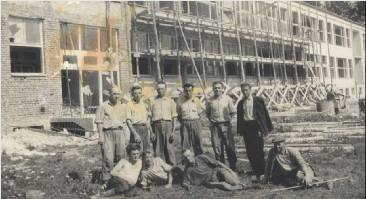
Budowa Szkoły Podstawowej w Radłowie, rok 1963. Na fot. brygada budowlana pod kierownictwem Mieczysława Sroki z Woli Radłowskiej (od prawej drugi, w marynarce). Zdjęcie ze zbiorów M. Sroki udostępnił Konrad Rudziński z Wał Rudy.
