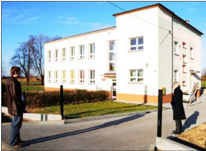
Front budynku ŚDS w Siedlcu
