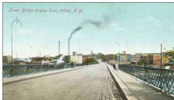
Ryc. 3. Widok z mostu
