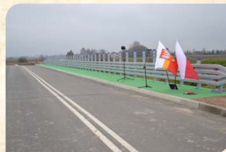
Most im. Plk. Władysława Kabata w Jadownikach Mokrych, w ciągu drogi powiatowej nr 1305K relacji Szczurowa – Żelichów oddany do użytku w listopadzie 2014 r.
