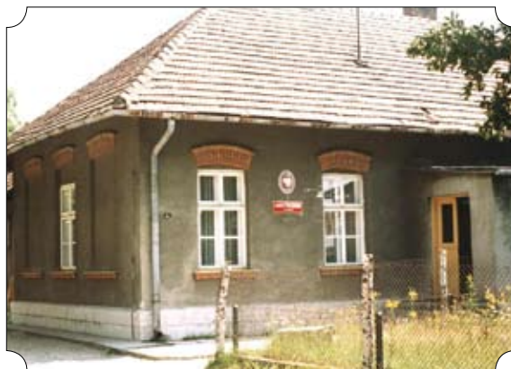
Budynek szkoły z lat 1912-1994
